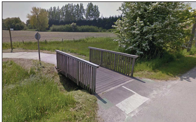
Passerelle existante (installée à Monchaux - Rue de la Dune aux Loups)
